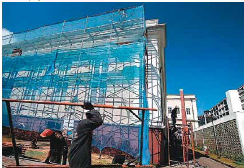
Prédio do TJPA passou por reforma em 2017
